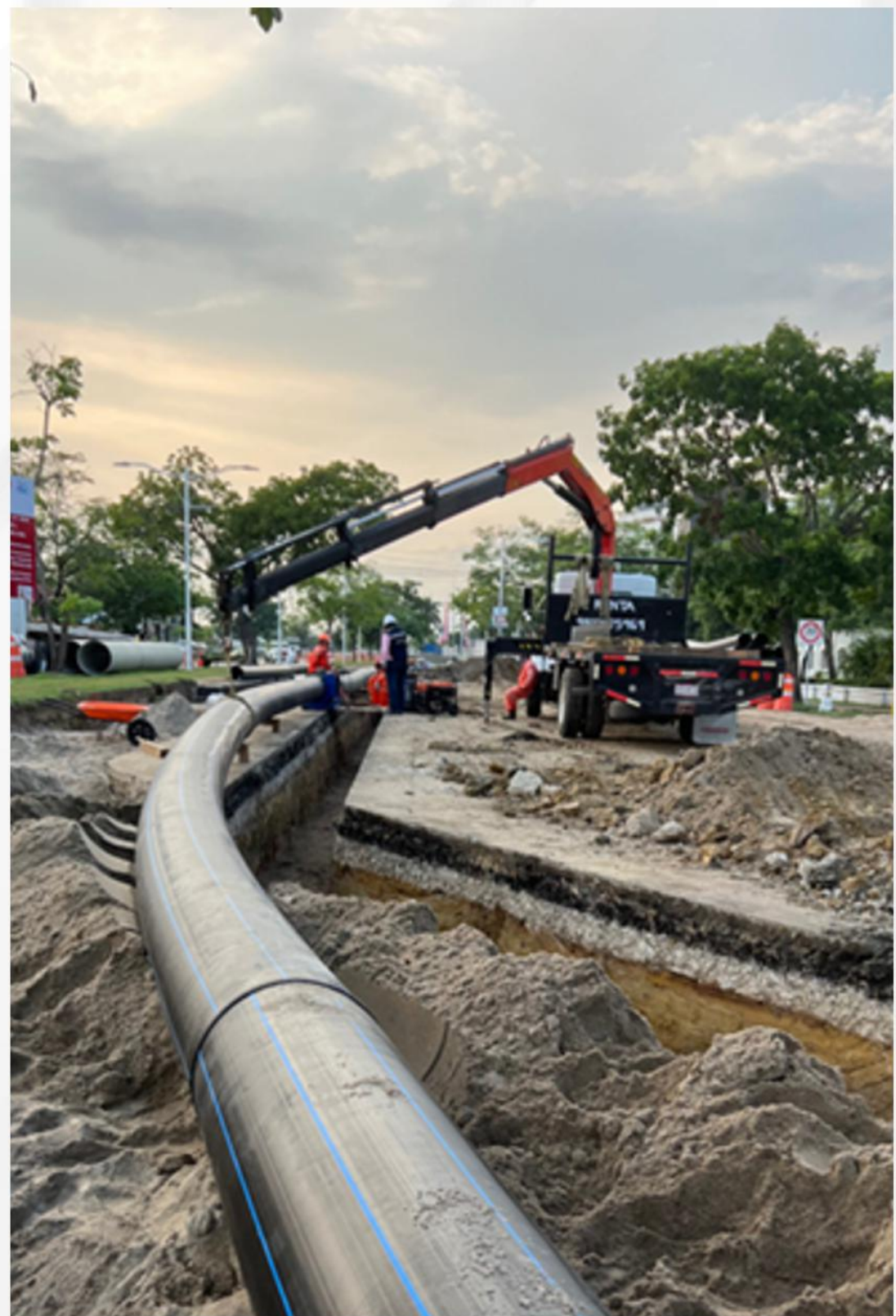
Construcción de acueducto con tubería de fibra de vidrio de 900 mm de diámetro y construcción de redes de tubería de servicios como drenaje sanitario, drenaje pluvial; en avenida Usumasinta, ciudad de Villahermosa, Tabasco. Agosto 2023
