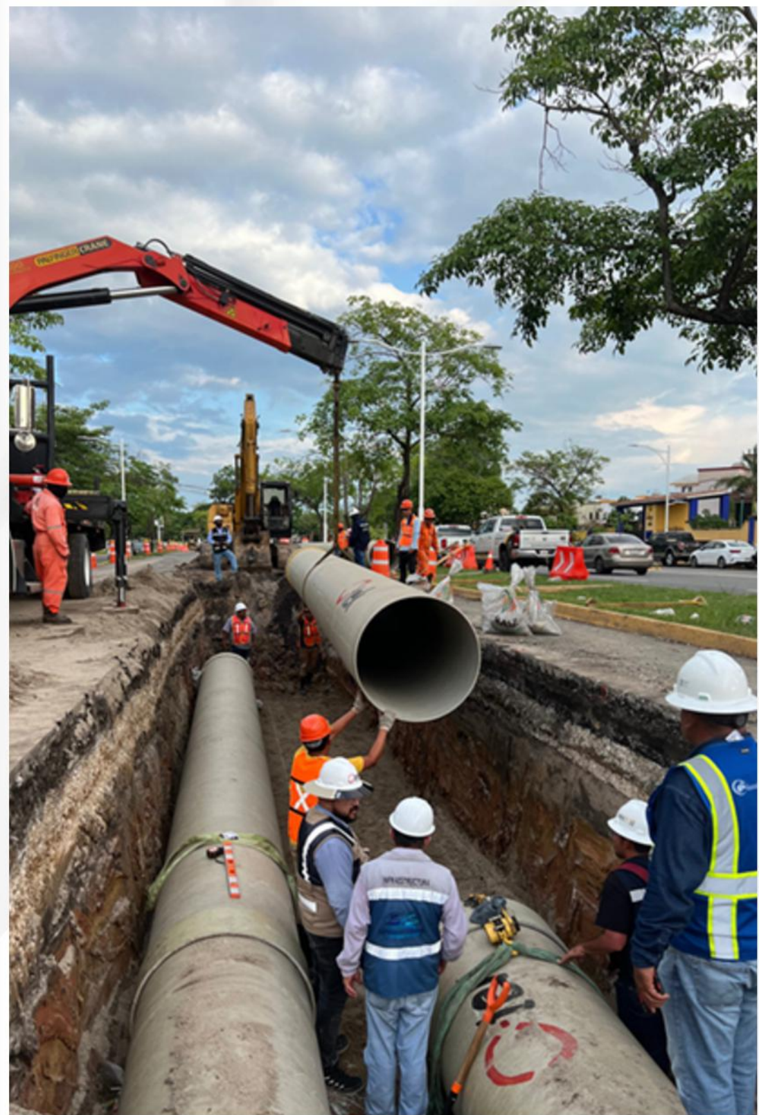
Construcción de acueducto con tubería de fibra de vidrio de 900 mm de diámetro y construcción de redes de tubería de servicios como drenaje sanitario, drenaje pluvial; en avenida Usumasinta, ciudad de Villahermosa, Tabasco. Agosto 2023
