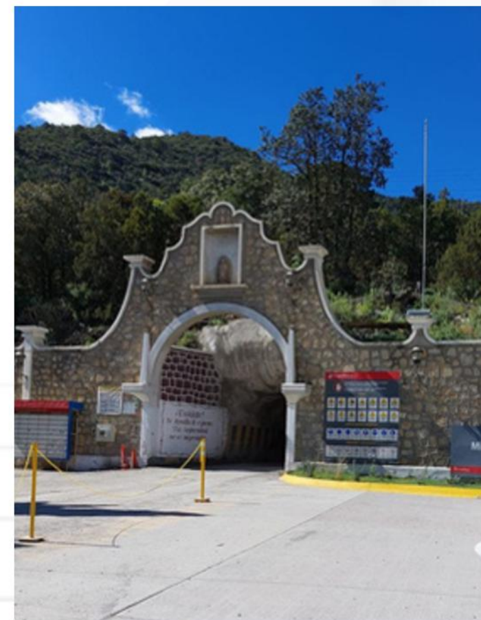
Rehabilitación de obras mineras subterráneas, colocación de concreto lanzado y anclaje Unidad Minera San Martin- Grupo Mexico 2017-2020
