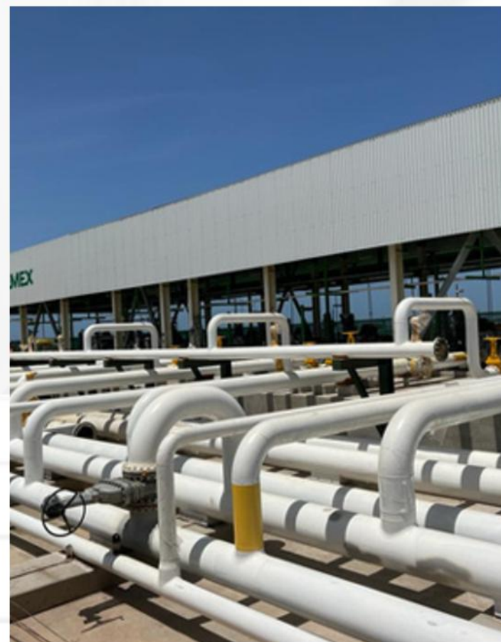
Construcción mecánica, soldadura especializada, aplicación de Sand Blast, aplicación de pintura de casa bombas 9003 "productos finales" de refinería Dos Bocas 2022- 2023 Pemex- PTI- Mepi
