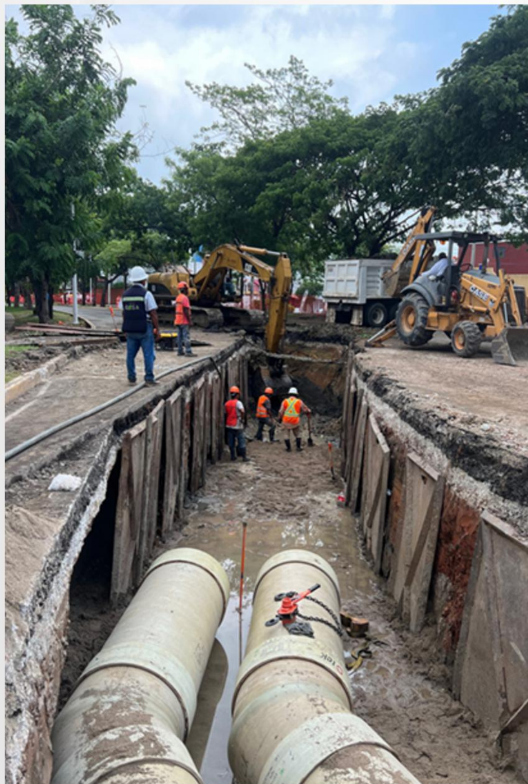
Construcción de acueducto con tubería de fibra de vidrio de 900 mm de diámetro y construcción de redes de tubería de servicios como drenaje sanitario, drenaje pluvial; en avenida Usumasinta, ciudad de Villahermosa, Tabasco. Agosto 2023
