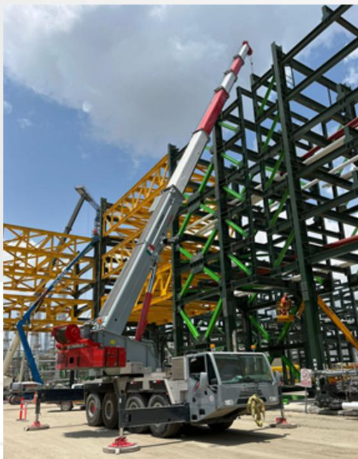
Construcción mecánica, soldadura especializada, maniobras e izajes de tuberías de servicios y procesos de refinería Dos Bocas 2020 2023 - Pemex- PTI- Proyecta
